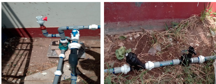
Figura 2.8. Instalación de la red hidráulica del sistema automatizado de riego por aspersión.
